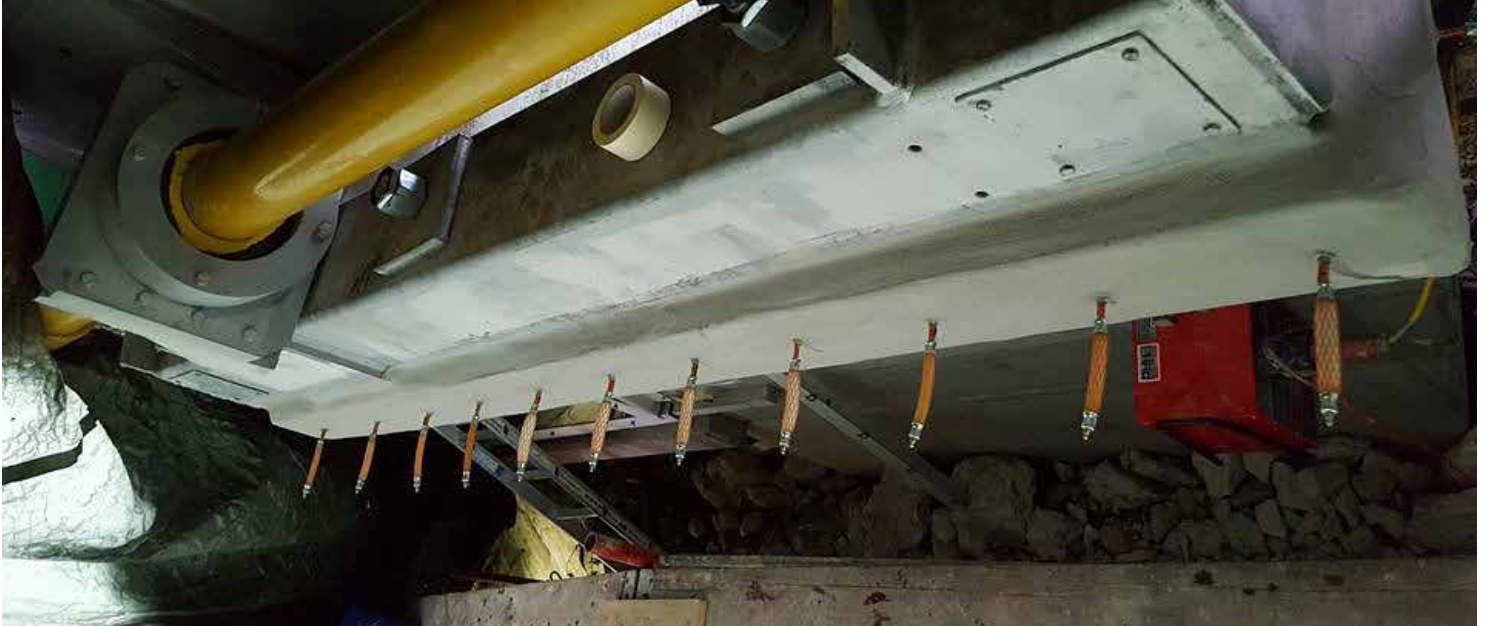
Bild 3: Durch die Kombination von Sika Klebepacker und Druckvorratsschläuchen ist ein kraftschlüssiges Füllen der Risse mit Sikadur®-52 Injection Normal optimal möglich
