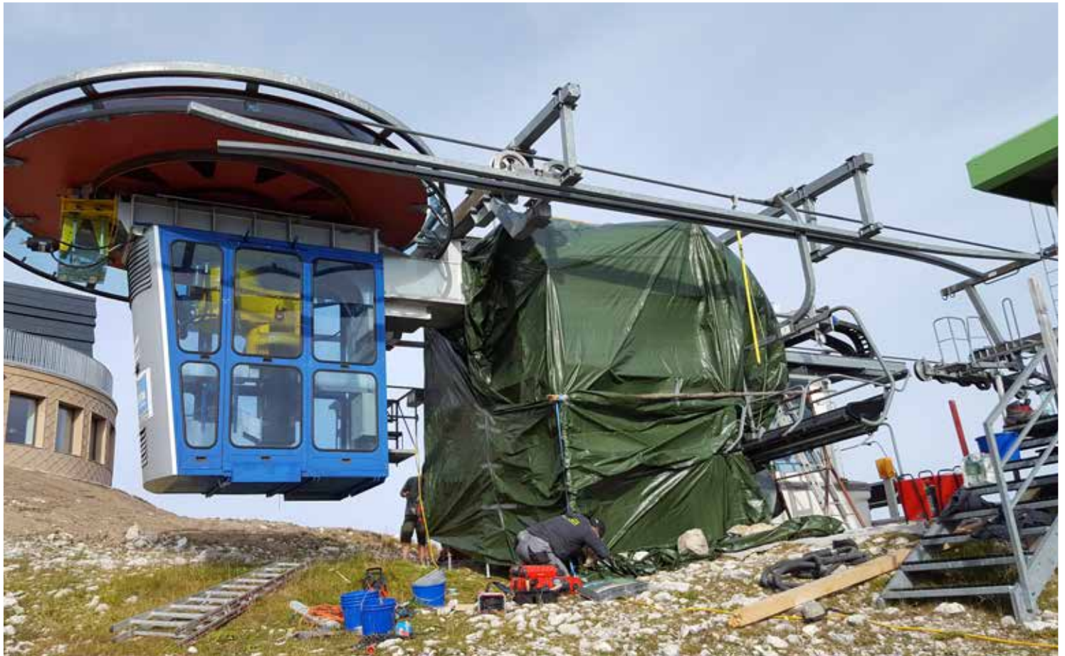
Bild 2: Eine komplette Einhausung der Liftstütze ermöglichte ein Temperieren des gesamten Arbeitsbereiches
