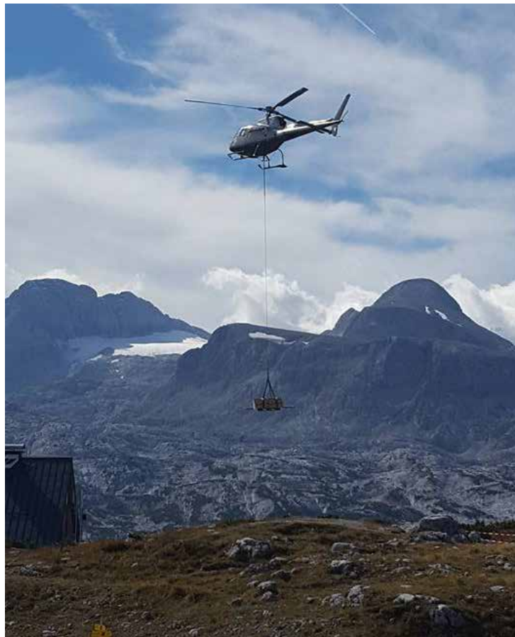
Bild 6: Lange Transportwege von der Bergstation der Gondelbahn bis zur teilweise verschneiten Sesselliftstation stellten eine weitere Herausforderung dar
