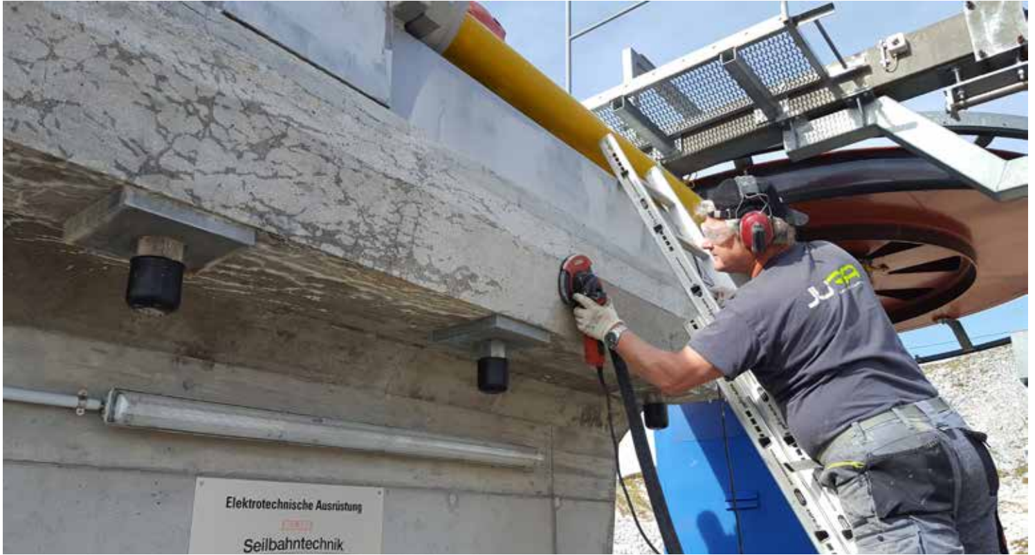
Bild 1: Nach Instandsetzung der Frostschäden und Abplatzungen erfolgte die professionelle Oberflächenvorbereitung für die nachfolgende Beschichtung
