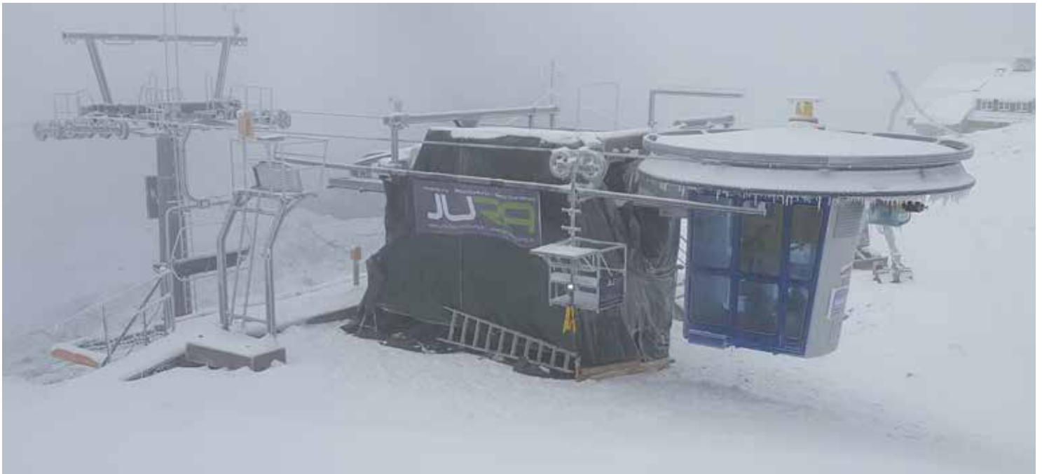
Bild 4: Auch bei einer Außentemperatur von -17°C und Schneesturm konnte durch spezielle Starkstromheizungen während der gesamten Arbeiten innerhalb der Einhausung eine Lufttemperatur von mind. +22°C erreicht werden
