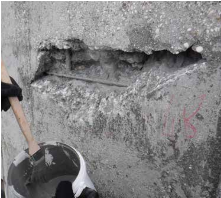
Bild 4: Entrostung und anschließende Behandlung des freiliegenden Bewehrungsstahls mittels Sika MonoTop®-1010
