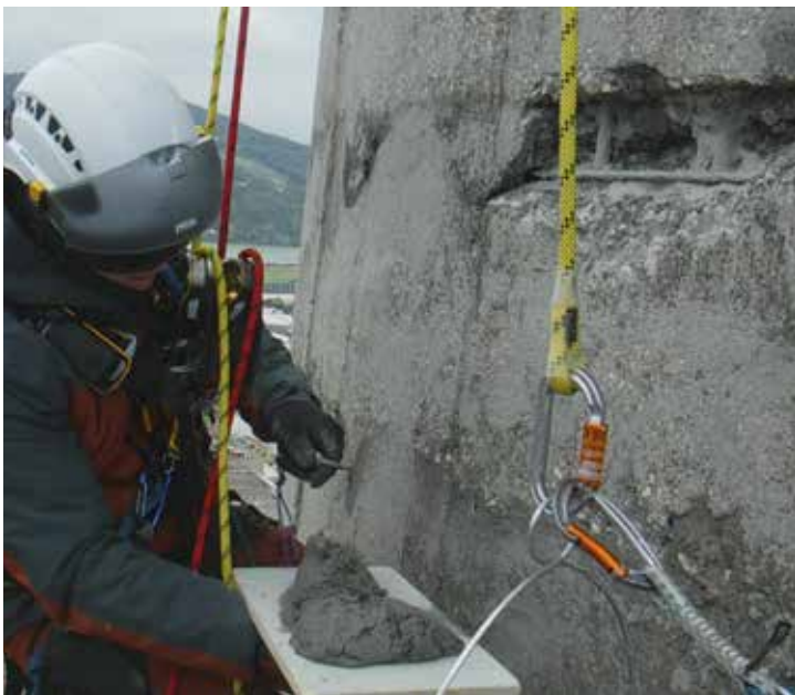
Bild 6: Die Schadstellen wurden mittels Sika MonoTop®-4012 / -3020 reprofiliert
