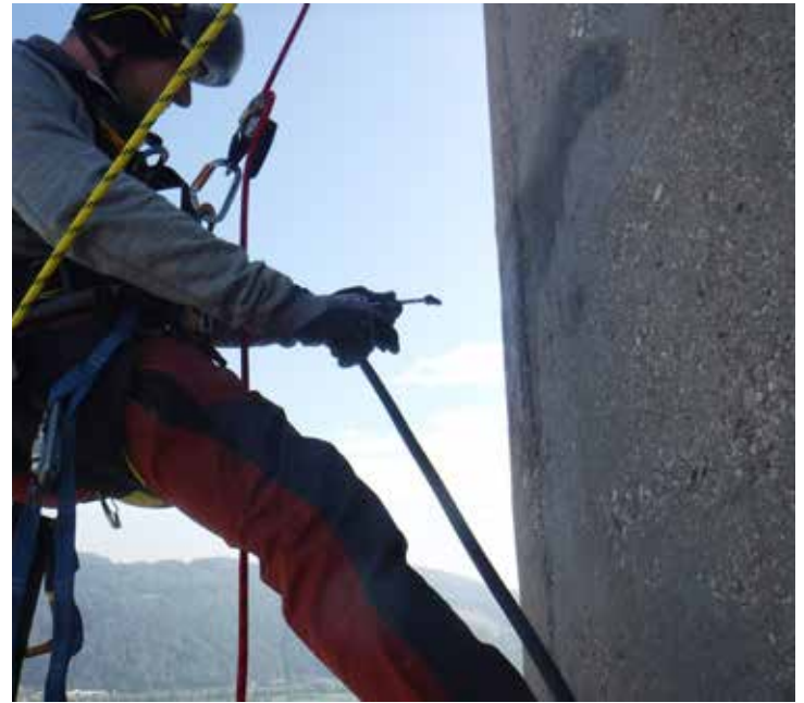
Bild 5: Durch das Vornässen wird verhindert, dass der trockene Untergrund das Wasser des Putzmörtels absaugen kann
