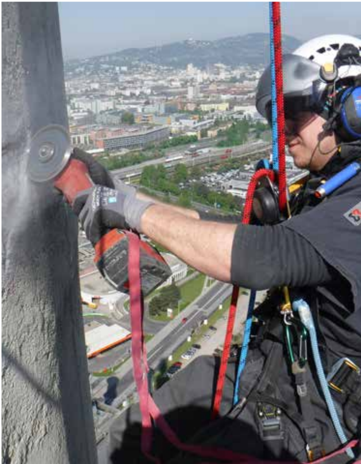
Bild 2: Mittels seilunterstützter Zugangstechnik konnte sicher gearbeitet werden
