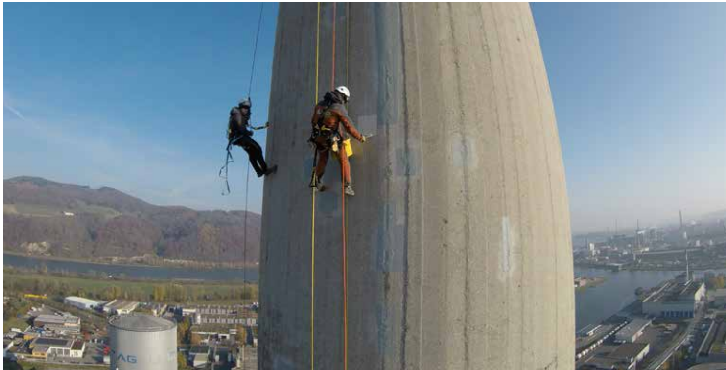
Bild 8: Eine Grundierung sowie die zweilagige Deckbeschichtung mit Sikagard®-550 schützen den Turm
